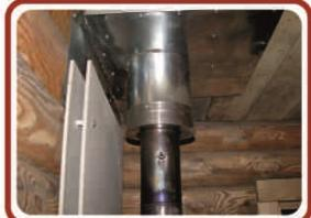
Соблюдать нормы противопожарной разделки (отступки) от горючих конструкций
